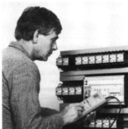
Het programmeren van een PLC.
